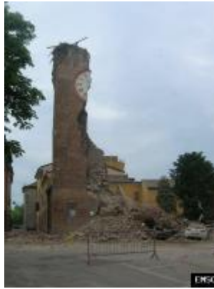
ο μισός πύργος του ρολογιού κατέρρευσε
